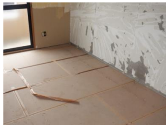
内装の解体工事
